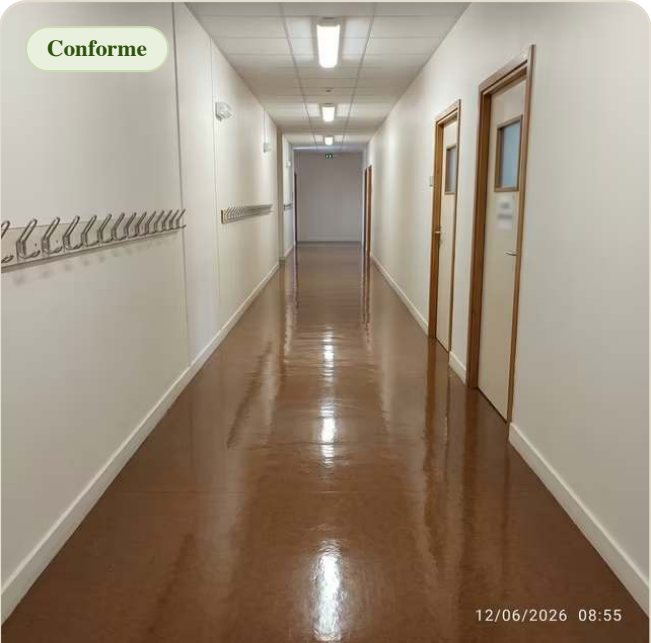
Circulations étage — sols nets, plinthes propres. Prestation conforme au CCTP.
