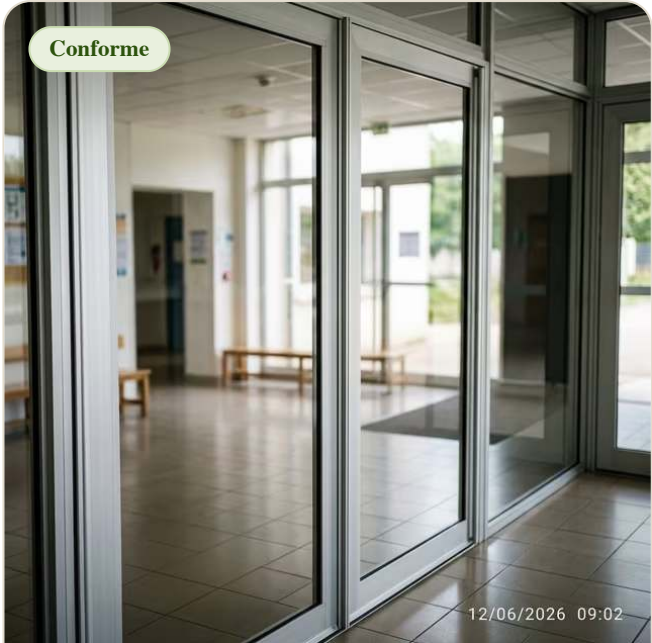
Vitrerie entrée — vitres nettes, encadrements dépoussiérés. Conforme au CCTP.
