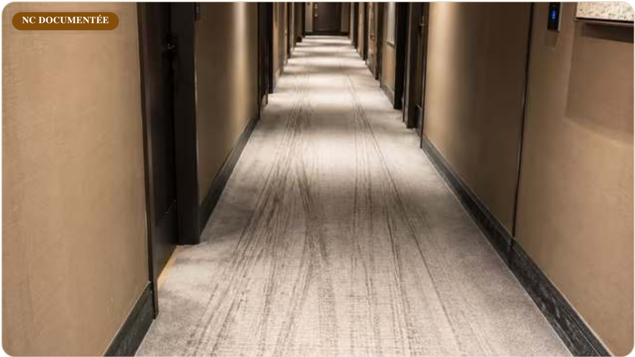
Cadrage : vue en enfilade du couloir, traces de roulettes de chariot visibles sur la moquette claire.
