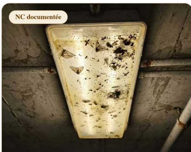
Luminaire N-1 — diffuseur encrassé
