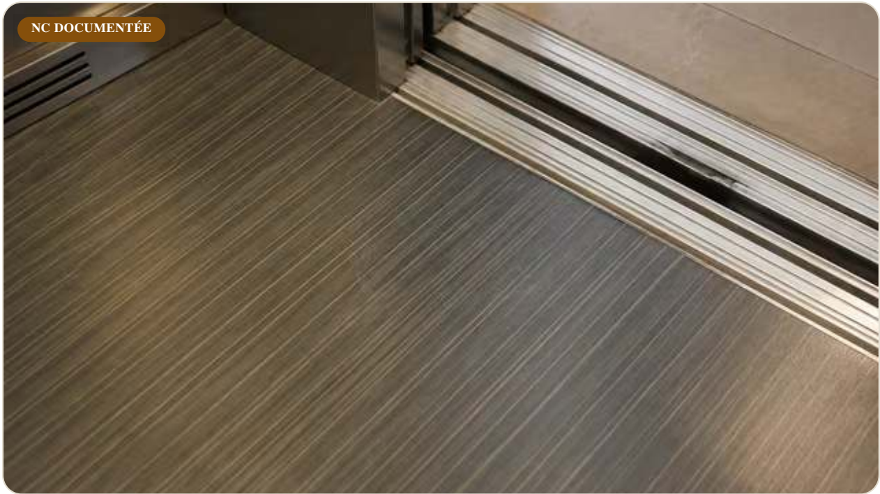
Cadrage : plan rapproché du sol de cabine et du joint de porte côté palier.
