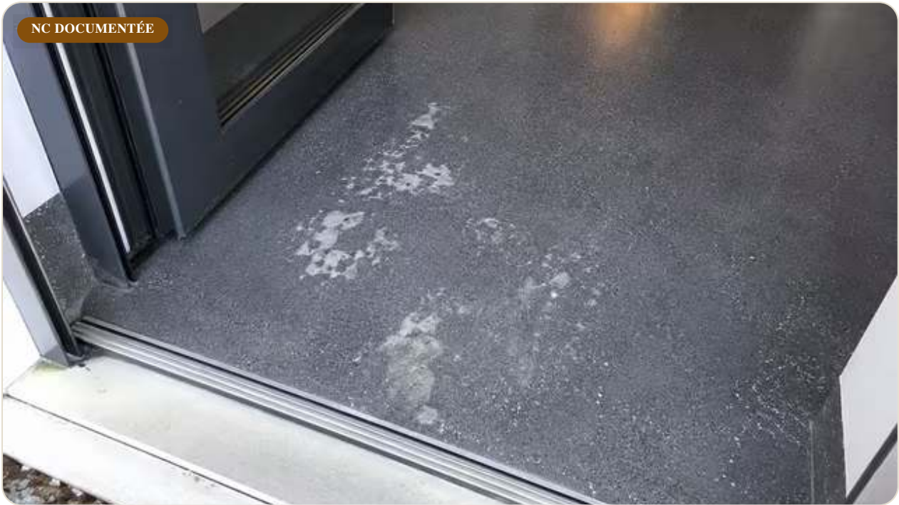
Cadrage : plan rapproché du sol résine au droit des accès, dépôt de mortier visible en lumière naturelle.
